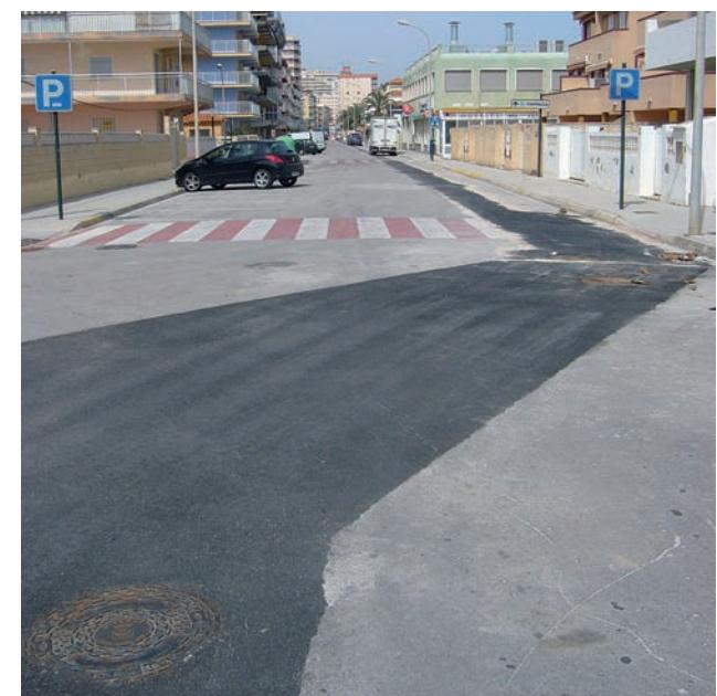
la instalación de colectores de mayor diámetro y la colocación de más imbornales con mayor capacidad de desague, con el objetivo de evitar las acumulaciones de agua que de manera puntual se producen en dichas zonas cuando llueve con cierta intensidad.
